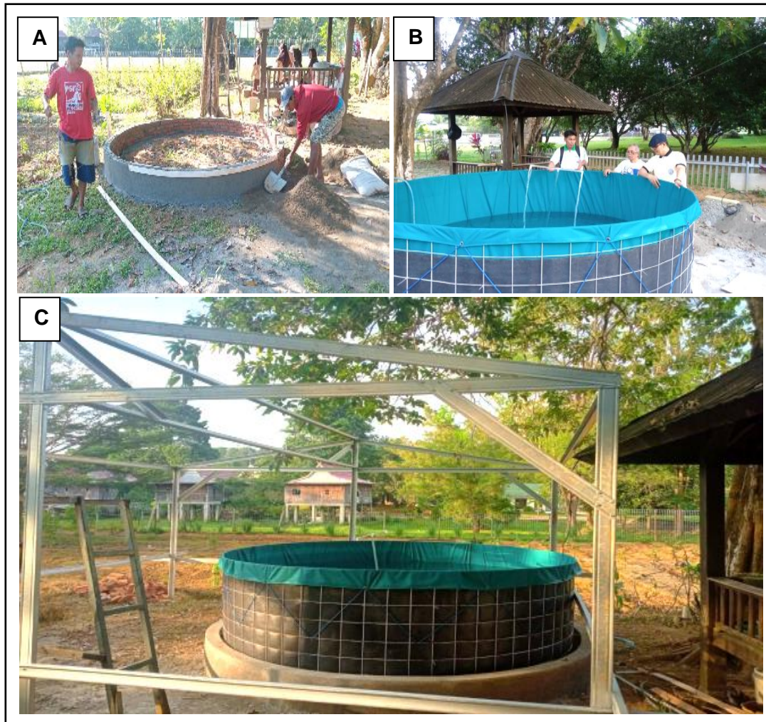
Gambar 6. Pelaksanaan Pendampingan Pemasangan Kolam Terpal Resirkulasi. (A) Pembangunan dasar atau alas kolam; (B) Kolam terpal sedang pengisian air; (C) Kolam terpal dengan rangka atap.
