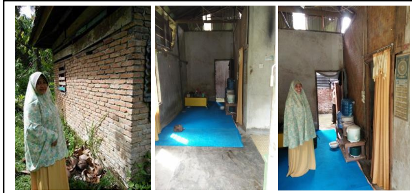
Gambar 2. Kondisi awal rumah penduduk.
